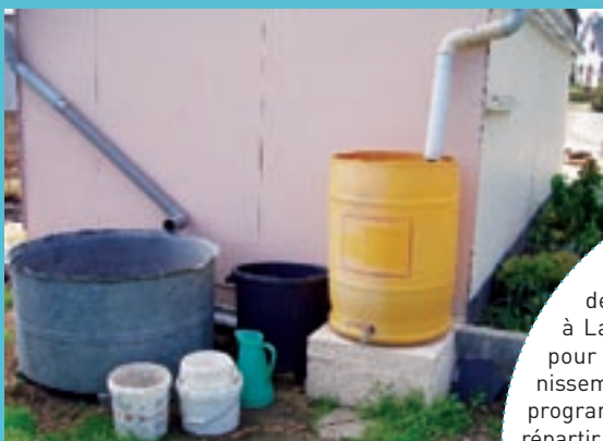
↓ L'eau de pluie récupérée peut servir à différents usages : arrosage, certains lavages, WC...
